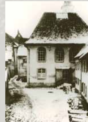
Frühere Synagoge Crailsheim
